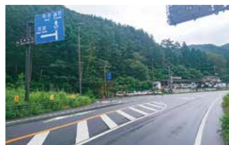
新たな御坂トンネル(予定地) (河口湖側)
