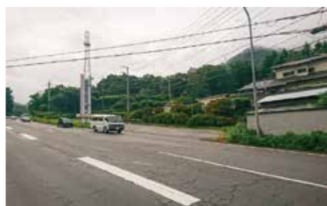
新たな御坂トンネル(予定地) (甲府側)
