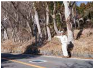
山中湖村「長池地区」防災工事
