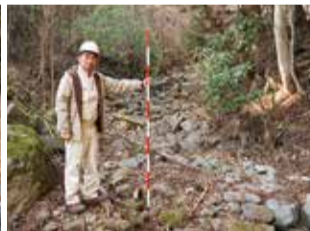
道志村平久住沢改修工事
